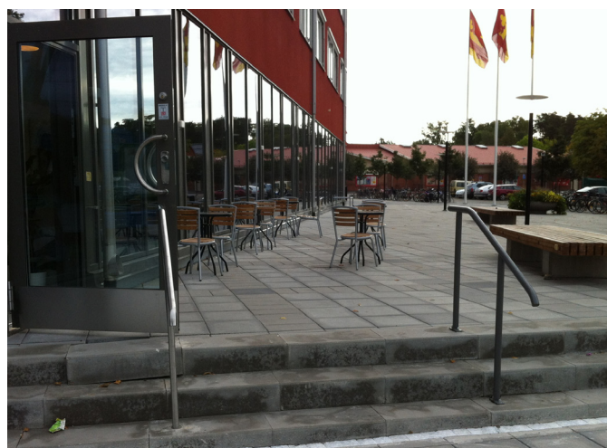
Kommunhuset sett från Centralvägen med trappa och ledstänger.
