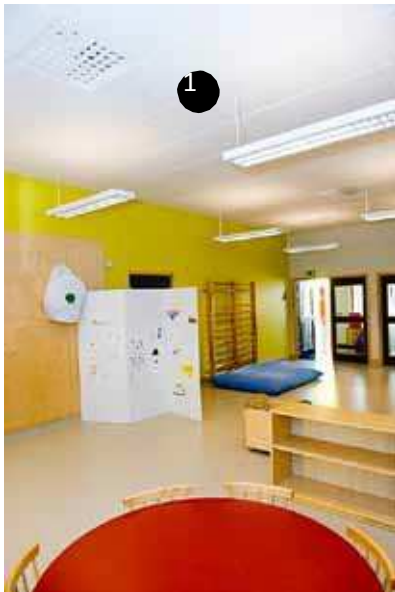
Akustikundertak (1) som dämpar bullret i lokalerna (efterklangstiden/eko).
